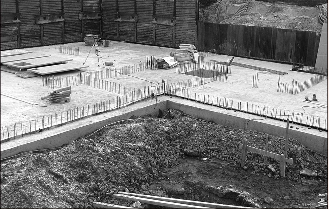
MASTER-Dichtblech ist in der Sohle einbetoniert. Die ersten Hohlraumwände liegen zur Montage bereit.
