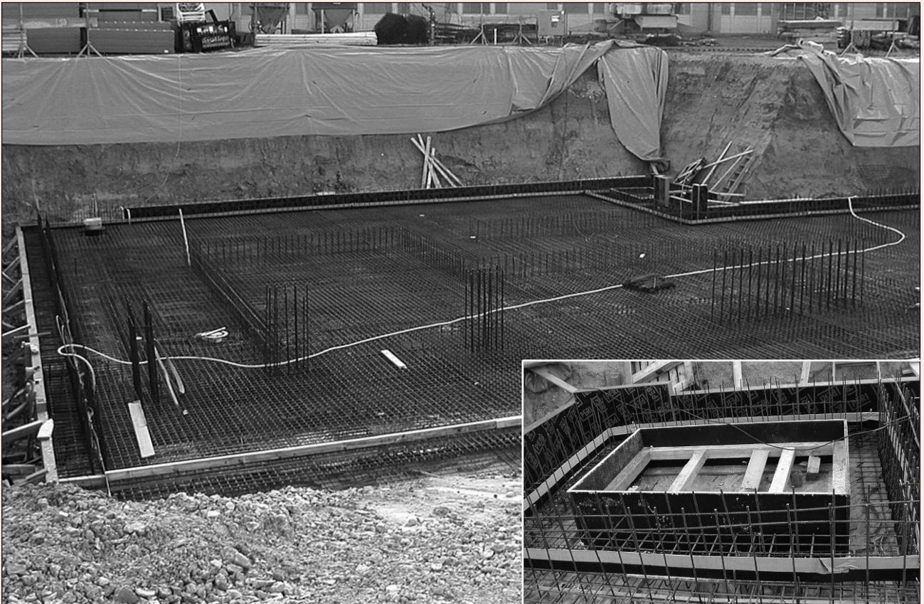
Mit MASTER-Dichtblech und den verschiedenen Abdichtungsprofilen werden Arbeitsfugen, im horizontalen und vertikalen Bereich, sicher und dauerhaft gegen drückendes und nichtdrückendes Wasser abgedichtet. Die Beschichtung der Profile ist beständig gegen sämtliche organische Abwässer.
