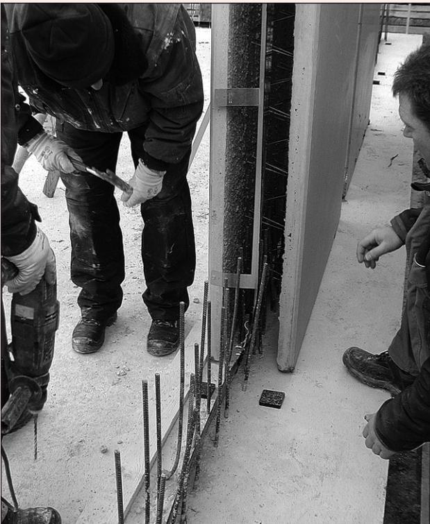
Die Hohlraumwand wird aufgestellt, dabei bildet MASTER-Dichtblech die Sohle/Wand-Abdichtung
