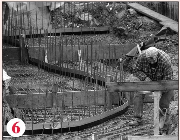
**6** MASTER-Dichtblech macht alle Biegungen mit. Auch Abdichtungen durch versetzte Ebenen lassen sich problemlos ausführen.
