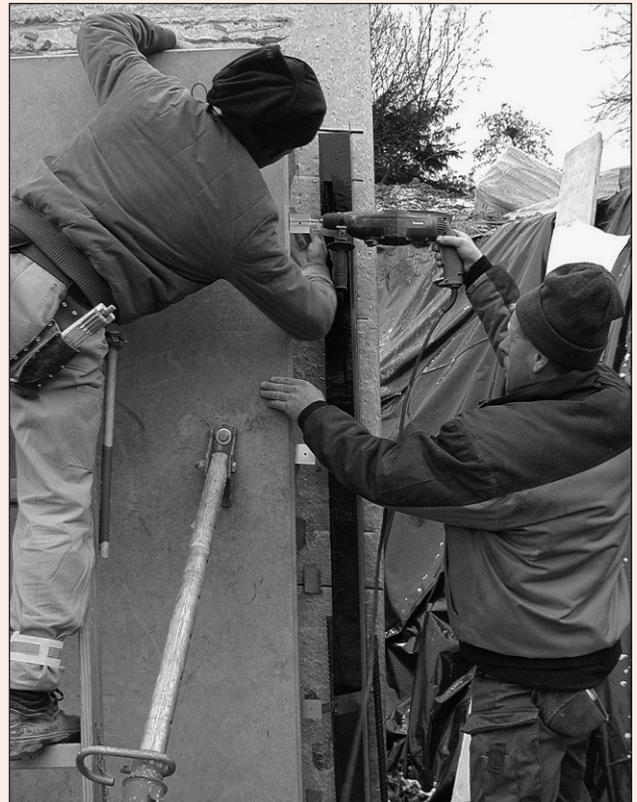
Befestigung eines Eckprofils. Die Laschen sind ebenfalls verstellbar.
