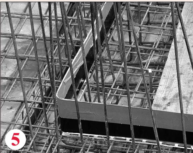
**5** Befestigung mittels Bindedraht an der Halteschiene. Im Eckbereich einfach abbiegen
