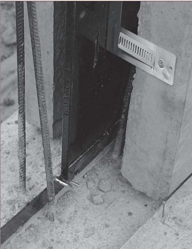
Durch die verstellbaren Laschen können die Wandprofile immer mit dem Bodenprofil verbunden werden.
