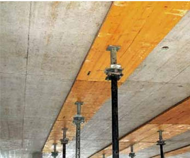
TITAN HV hat keine betonberührenden Bauteile. Daher ist auch die Reinigung einfach und kostengünstig.
