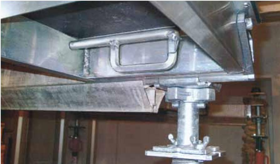
Anschieben der Combi Paneele bis zur Wand möglich. Paneele und Hauptträger bilden eine schubsteife Deckenscheibe, die planmäßig alle horizontalen Ersatzlasten nach DIN 4421 gegen Säulen und Wände abstützt.
