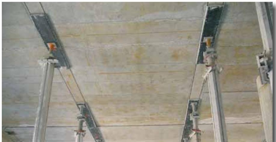
Ausgeschaltete Deckenunterseite mit Notstützen. Combi Paneele und Hauptträger konnten ausgeschalt und im nächsten Betonierabschnitt wieder eingebaut werden. Lediglich einige Passstreifen verbleiben über den Notstützen.
