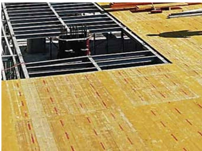
Die Schalhautplatten werden richtungsgleich zum Hauptträger verlegt. Sie sollten nicht auf den Hauptträger gestoßen werden, da so beim Frühausschalen viele Platten freigesetzt werden können.
