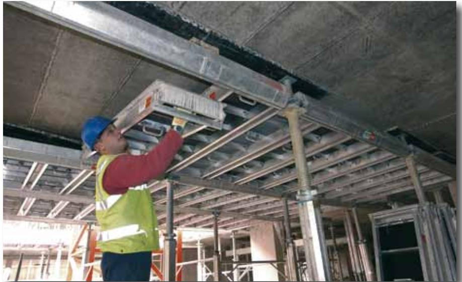
Durch das einseitige Schwenklager ist ein einfaches Ausschalen von unten möglich.
