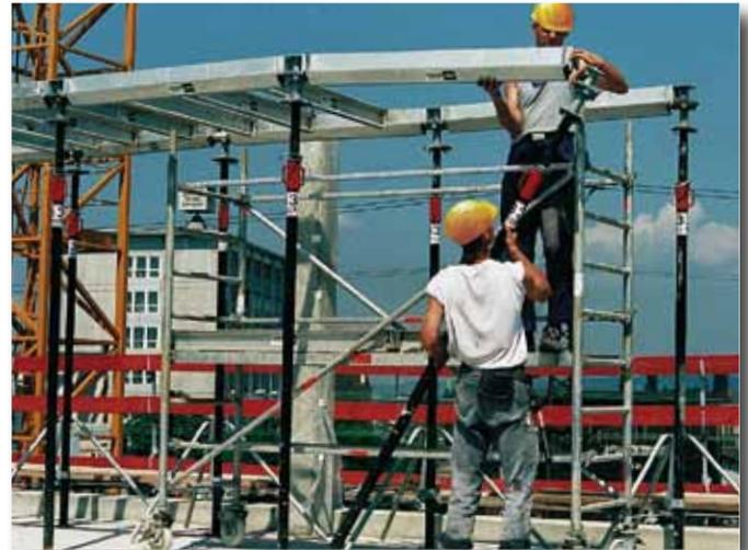
Anheben des Hauptträgers mit der nächsten Stütze. Die Stütze ist positioniert.
