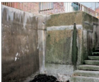
Beanspruchung durch die Verwendung von Trennmitteln (Algenbildung)
