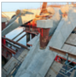
Brücke Gignac (FR), 2007
