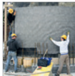
Wasserbehälter Trin (CH), 2008
