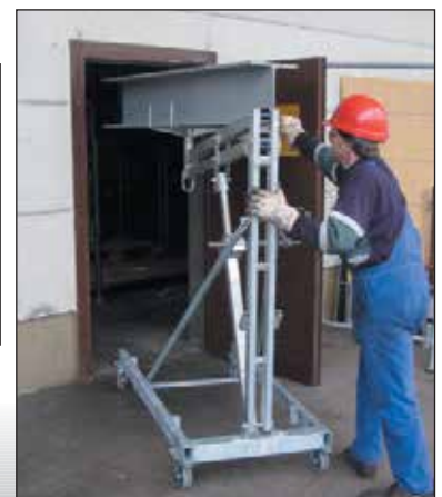
Einsatz eines Stahlträgers mittels zweier Kragarmlifte. Durch Kurbeln läßt sich der Stahlträger in die gewünschte Höhe befördern.
