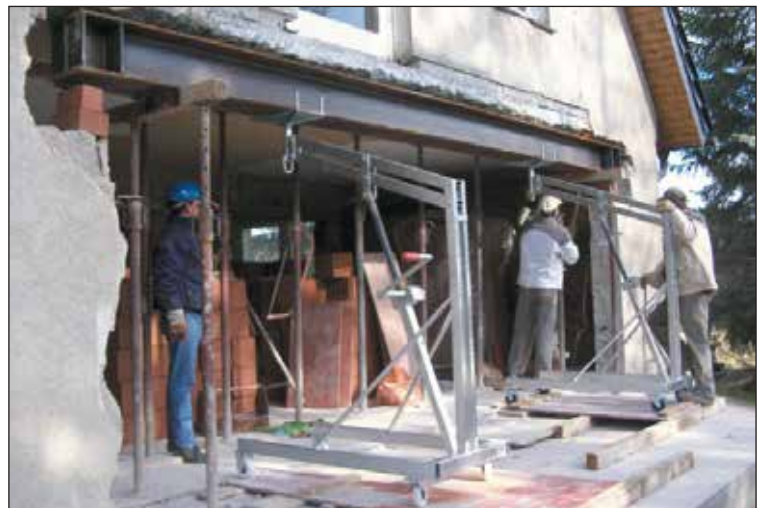
Einsatz eines Stahlträgers mittels zweier Kragarmlifte. Durch Kurbeln läßt sich der Stahlträger in die gewünschte Höhe befördern.
