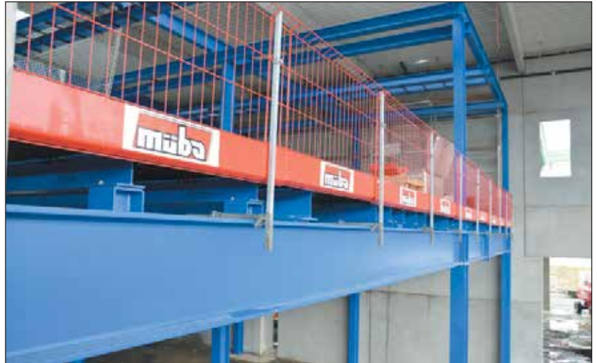
AS- System im Einsatz mit T-Trägerklemmen
