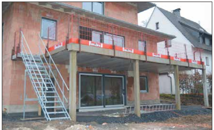
AS- System im Einsatz mit T-Trägerklemmen
